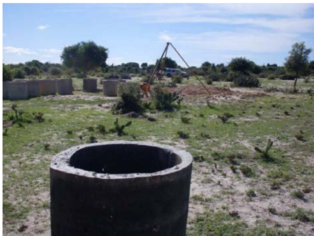
Le point idéal pour la construction du nouveau puits se trouve à 18 m de l'endroit initial
