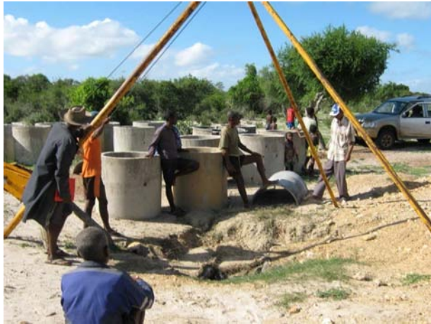
Les buses préfabriquées, les moules à buses et la chèvre tripode encore sur les lieux.
