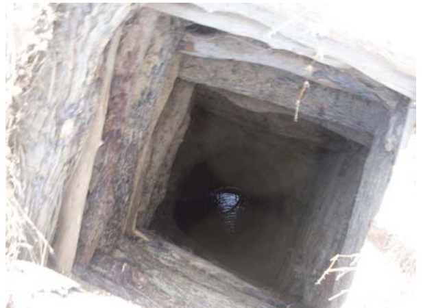
Le premier puits creusé : profondeur totale = 15,20 m ; hauteur d'eau = 5.20 m
